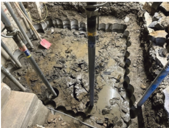
Für den Aufzug muss massiver Fels aufwändig herausgebohrt werden
