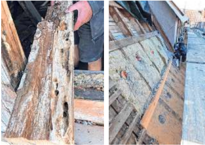
links: Zerstörung der Holzbalken durch Feuchtigkeit und Holzschädlinge, rechts: zusätzlich notwendige Dämmung des Dachs
