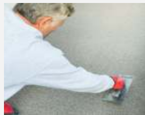
3. Die Colorquarz-Beschichtung wird von Hand gespachtelt
