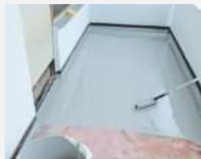
2. Beim Einbringen der Dichtschicht mit Gewebeeinlage ist Know-how gefragt
