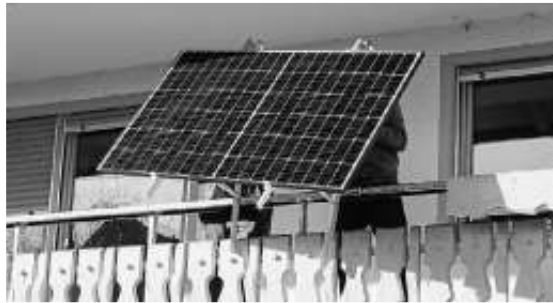
Installation eines Balkonkraftwerks
