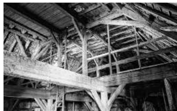
Beeindruckend: Die Fachwerk- und Dachkonstruktion der Scheune in gut erhaltenem Originalzustand
