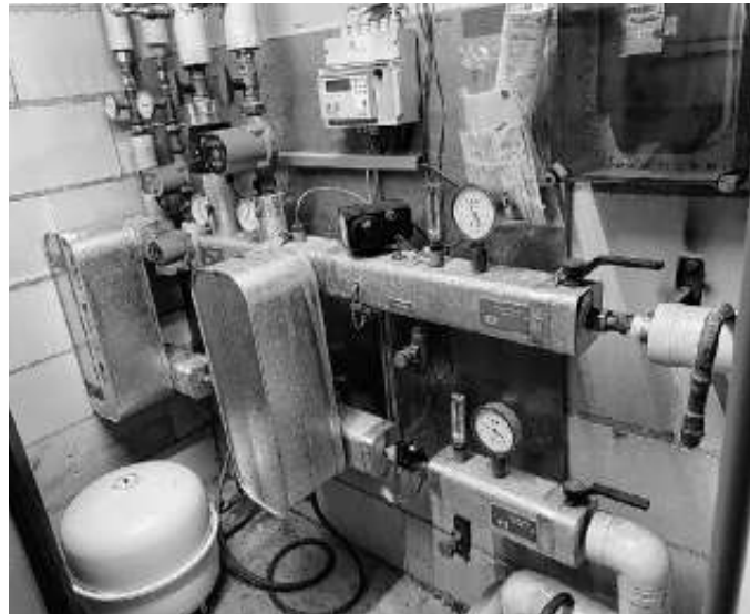
Fernwärmeheizung eines Mehrfamilienhauses.
