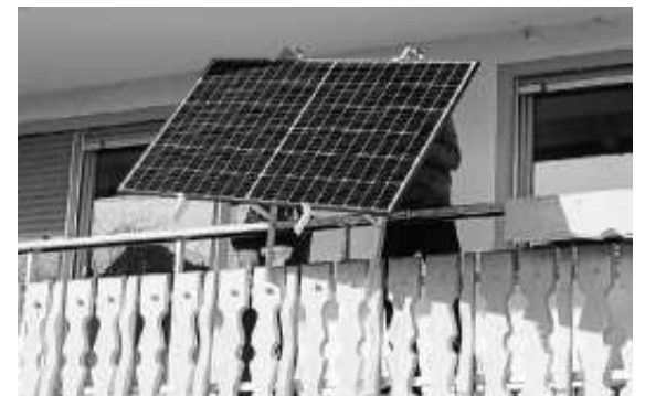
Installation eines Balkonkraftwerks
