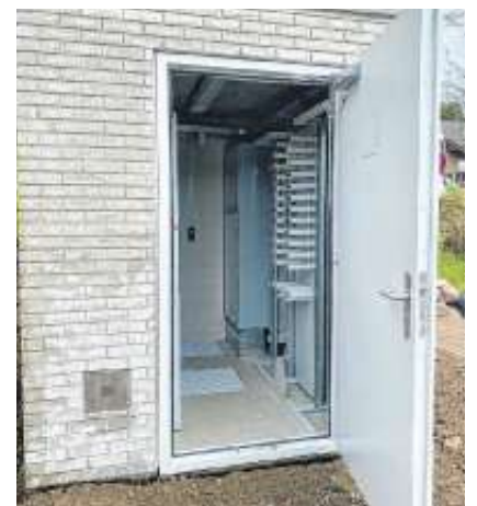
Sogenannte Points of Presence bieten viel Platz für die nötige Glasfaser-Technik.
