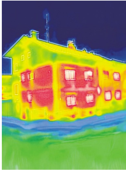
Ansicht eines Mehrfamilienhauses mit der Wärmebildkamera Bild: iStock.com / ivansmuk
