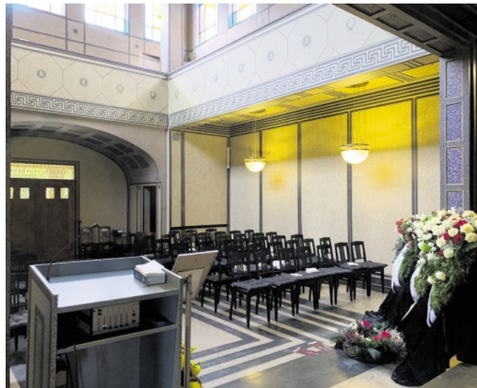
Veraltete Technik, marode Substanz: Die Trauerhalle auf dem Alten Friedhof muss dringend saniert werden.
