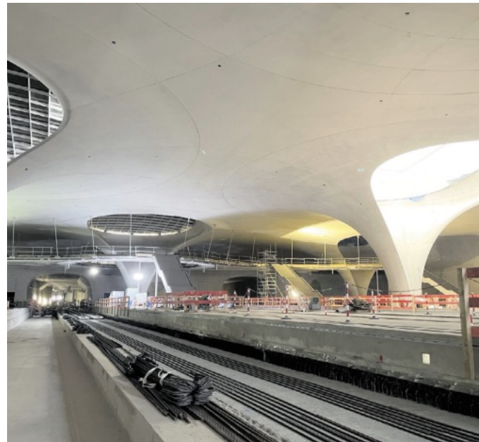
Stuttgart 21 und der Pfaffensteigtunnel
