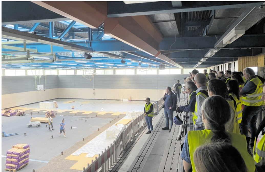
Die Murkenbachhalle I wird grundlegend saniert, behält aber ihre Grundstruktur bei. Die umfangreichen Arbeiten beinhalten die Erneuerung der Beleuchtung, des Sportbodens, aller 35 Lichtkuppeln sowie der Prallwände. Zudem werden Optik und Akustik der Murkenbachhalle I verbessert.
