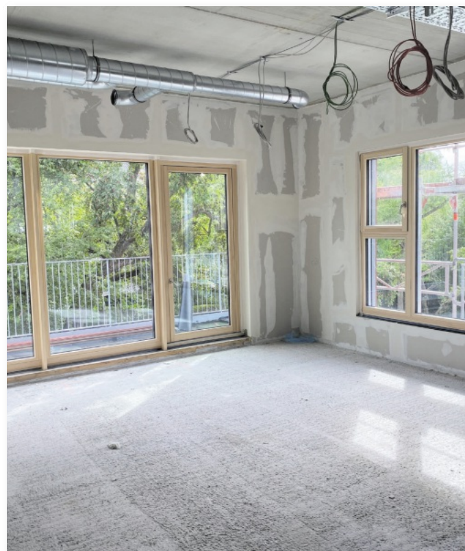
Beim Neubauprojekt der Kindertagesstätte in der Breslauer Straße 21 konnte sich der Gemeinderat einen Eindruck verschaffen, wie die Baustelle mit dem zweigeschossigen Baukörper für eine fünfgruppige Kindertagesstätte mit 85 Kitaplätzen direkt neben der bestehenden Kita Breslauer Straße 17-19 voranschreitet.
