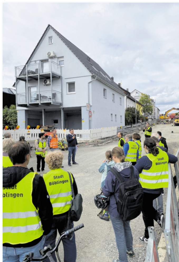
Die Sanierungsarbeiten im Bereich Schönaicher Straße Nord befinden sich derzeit am Ende des vierten Bauabschnitts, bevor voraussichtlich am Donnerstag, 9. Oktober, der fünfte und letzte Bauabschnitt beginnt. Vor Ort wurde verdeutlicht, wie bei der Maßnahme die Wasser- und Gasleitungen sowie die Straßenbeleuchtung erneuert sowie die Abwasserschächte saniert werden. Abschließend wird die Fahrbahn-Oberfläche in voller Breite neu asphaltiert.
