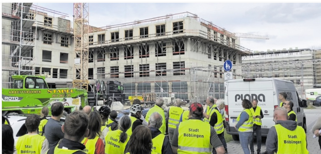
Am Neubau des Zentrums für Seelische Gesundheit auf dem Flugfeld bekam der Gemeinderat einen Einblick in den Baufortschritt des nachhaltigen Projekts mit modernen Strukturen. Es bündelt die wohnortnahe psychiatrische Versorgung sowie die stationären und tagesklinischen Angebote an einem Standort. Zudem wird die Zusammenarbeit insbesondere durch die enge Verbindung mit dem benachbarten Flugfeldklinikum gestärkt.
